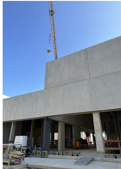
Der Richtkranz verkündet weithin sichtbar den Eintritt in die nächste Bauphase.
