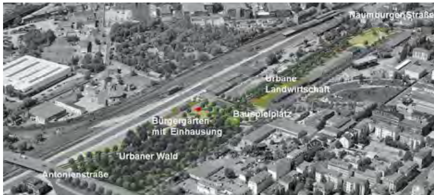
Bürgerbahnhof Plagwitz, Flächen nördlich der Antonienbrücke, Foto: Machleidt GmbH, Berlin
