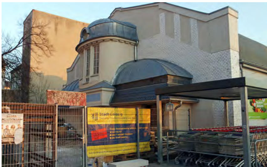
Eingangsbereich noch im Baustellenmodus
