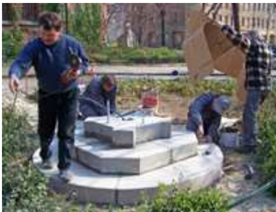
Mehrstufiger Betonsockel
