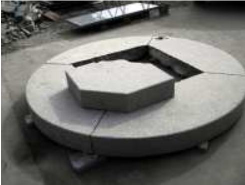
Sanierter Unterbau und Sockel
