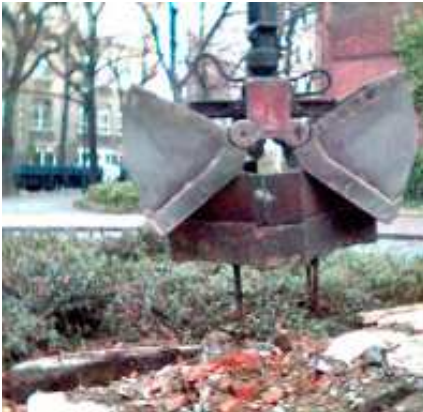
Abbau des Sockels zur Restauration
