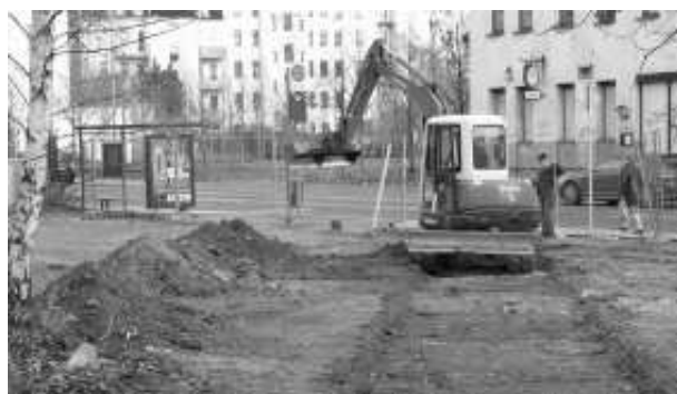
Baustart an der Ecke Wurzner/Hermann-Liebmann-Straße.
