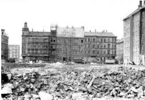
Blick auf die noch unsanierte Häuserfront Elisabethstraße. Im Vordergrund wird die Baugrube fürs Karree zwischen Zollikofer- und Konradstraße entstehen.
