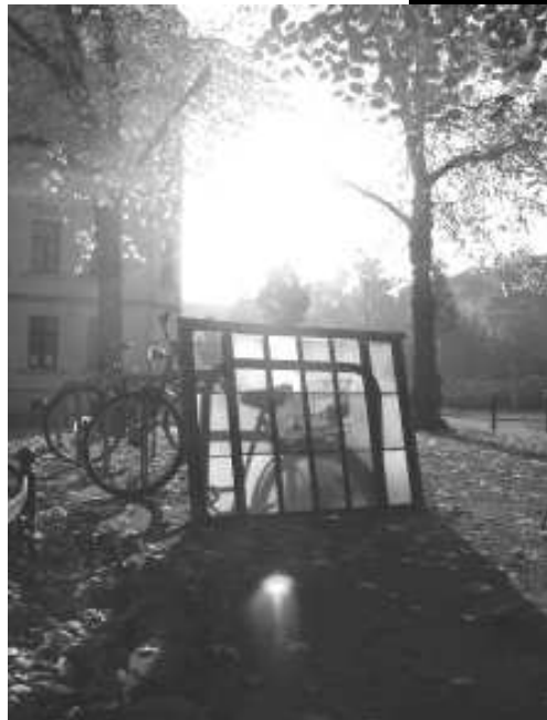
Neustädter Impressionen: Fenster- sanierung der Heilig-Kreuz-Kirche
