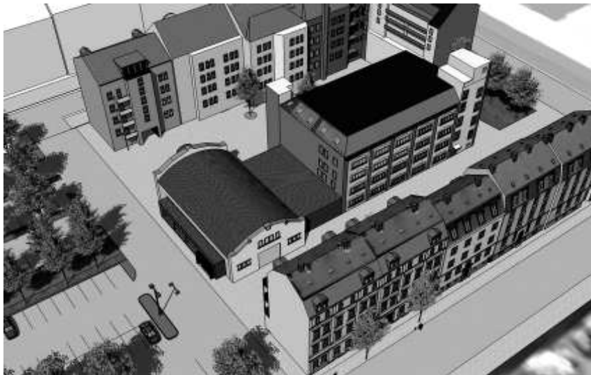
Die Aussicht für 2008: Ein Aldi-Markt steckt in der sanierten Markthalle und reicht bis ins Erdgeschoss des Nachbarhauses.
