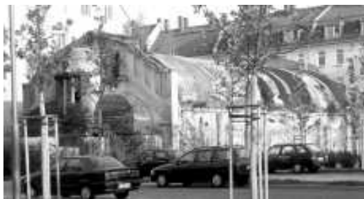
Der heutige Zustand: Die alte Markthalle mit dem prächtigen Portikus verfällt.
