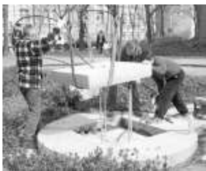
Maßarbeit: Der Sockel wird gesetzt...
