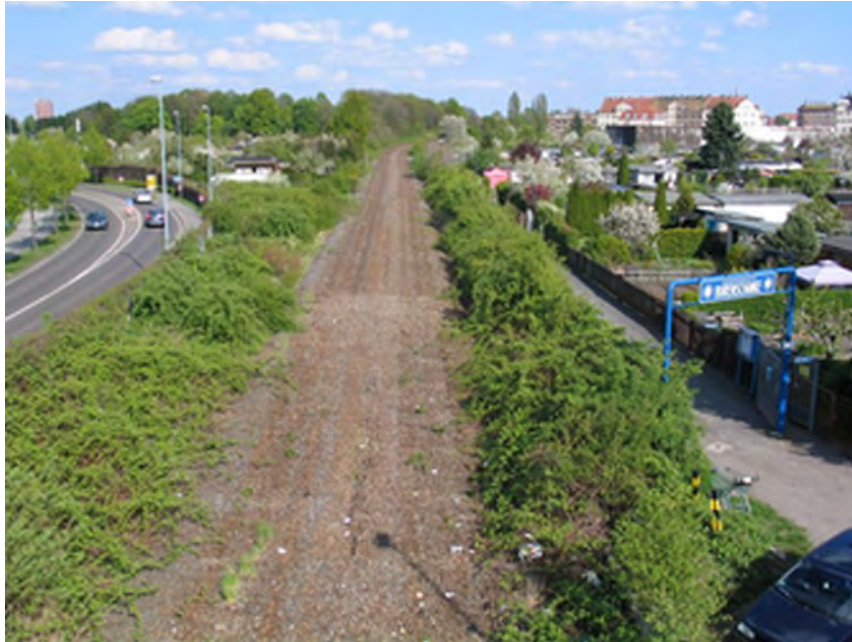
Führt hier demnächst der Parkbogen Ost entlang?
