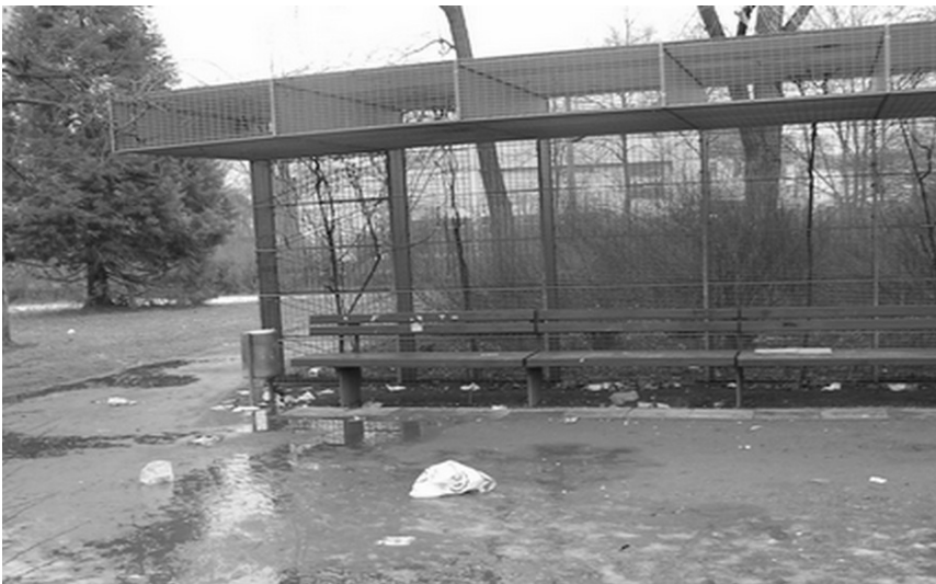
Verwahrloste Laube im Reudnitzer Park
