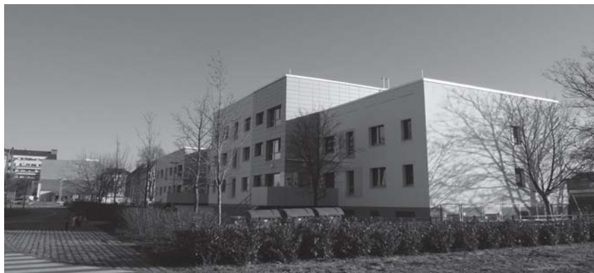
Die Kita in der Eisenbahnstraße 52 nach ihrer Sanierung.
